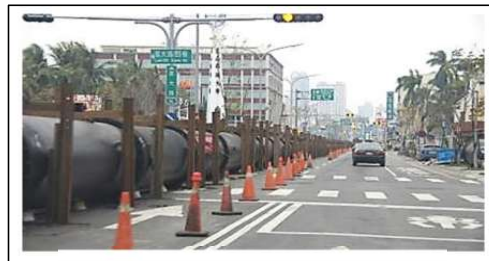
於崑山路鋪設明管復水
