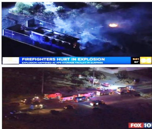
4/26美國亞利桑那州瑟普賴斯市，2MW鋰電池儲能系統廠冒煙後起火爆炸。
